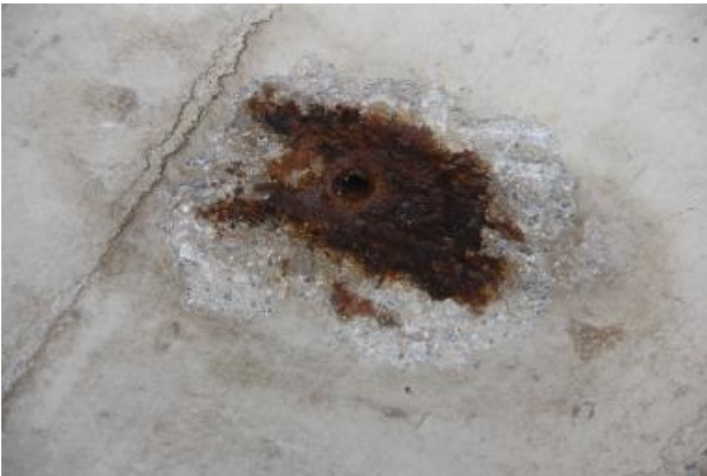
Foto 12: A; K; W bei Abdichtungsentwässerung
