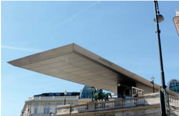
Abbildung 3: Detailfoto: Soravia Wing der Albertina Anmerkungen: Soravia Wing am Dach des Entrees der Albertina, 60 m auskragender Flügel, welcher die Rolltreppe und den Panoramalift beherbergt und die Modernisierung der Albertina symbolisch nach außen darstellen soll
